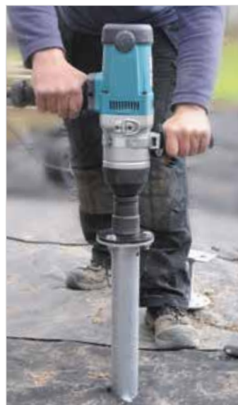
L'adaptateur 41 mm assure la connexion entre la machine (boulonneuse, visseuse) et la vis de fondation.
