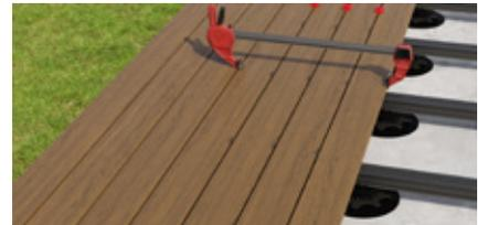
L'usage de serre-joints est recommandé pour un vissage optimal et rapide des clips Hybrid.
