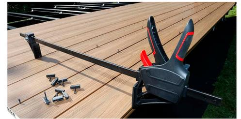
\* L'usage de serre-joints est recommandé. Il facilite et optimise l'opération, permettant un vissage rapide et précis de plusieurs lames à la suite.
